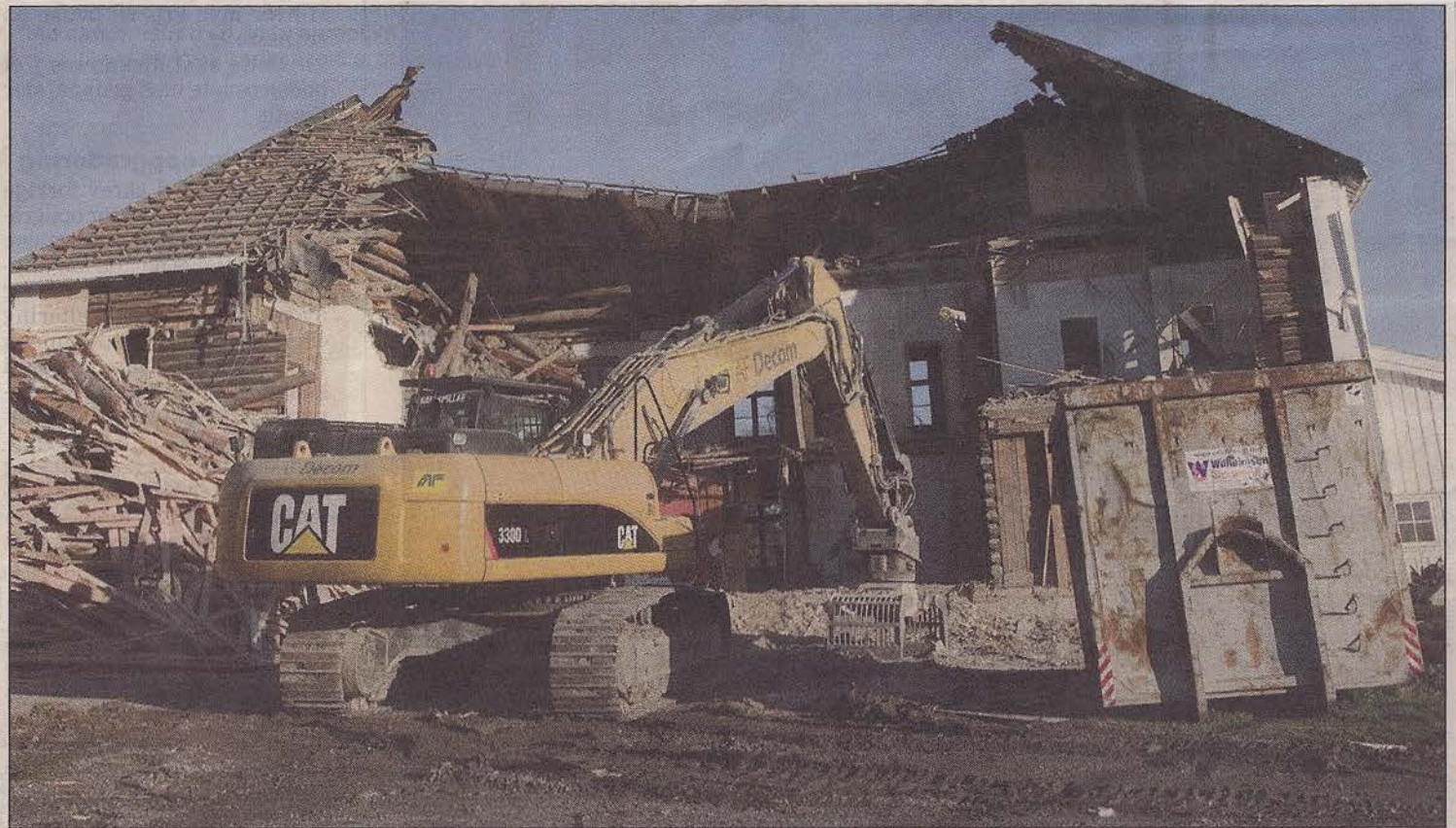
BORTE: Gamle Nordli gård er borte. Men fortsatt er ikke alt klart til byggestart for den nye barnehagen. Kommunen har ikke signert avtale med berørte grunneiere der adkomstveien skal utvides.
